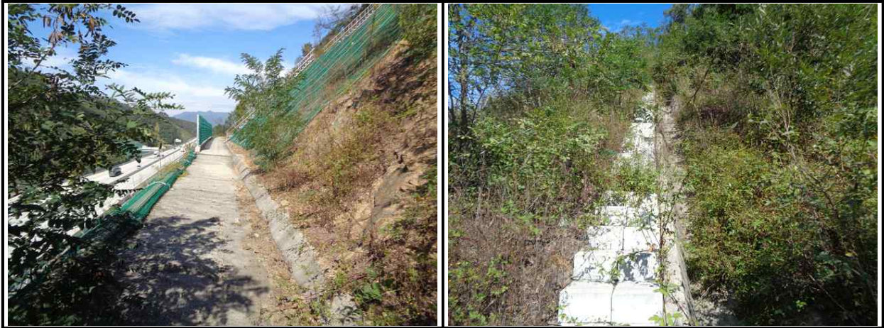
【그림 56.3.3】 배수시설 전경
