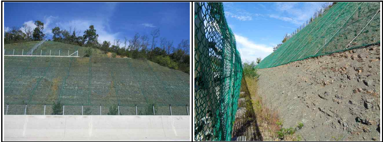
【그림 56.3.4】 보호/보강시설 전경
